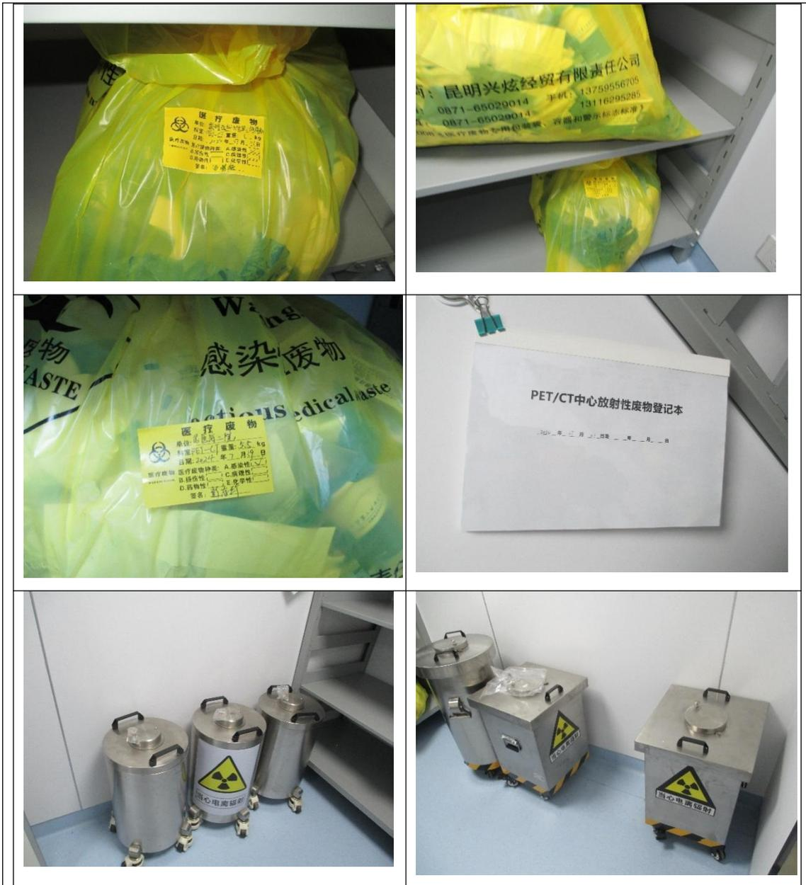
图 3-7 放射性固体废物收集
