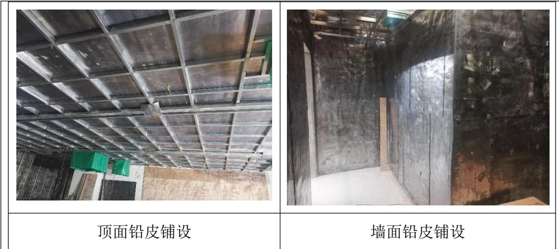
图 3-5 隐蔽性工程照片
